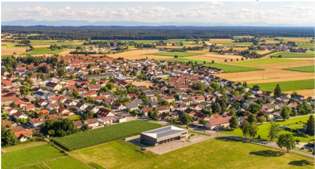
Blick von oben auf die Wache der Freiwilligen Feuerwehr Forstern
